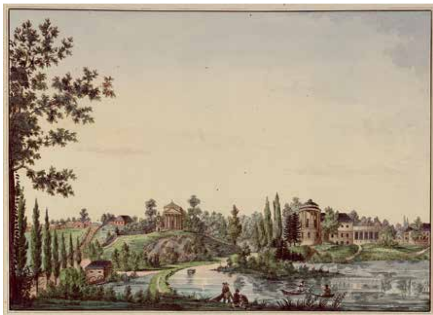
Żarzecz. Widok ogólny na część pałacowo-ogrodową. Na pierwszym planie – staw z wyspą na rzece Mlecze; z lewej strony – młyn, a na dalszym planie, wśród drzew – kościół i pałac za: M. Morska, Zbiór rysunków , Wiedeń 1836
