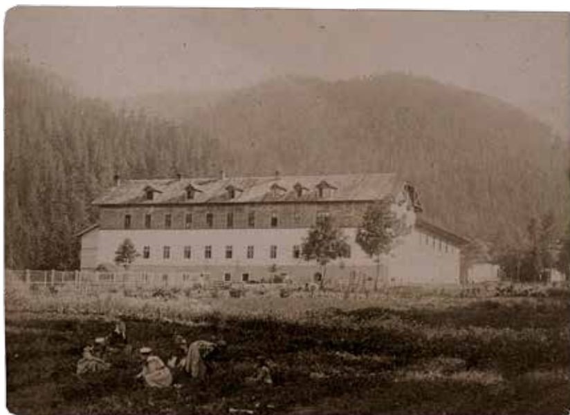
Zdjęcie górne – wejście główne do Szkoły Domowej Pracy Kobiet od strony północnej, dolne – widok na szkołę od strony południowej. Na zdjęciu cepculki z góralkami przy pracy w ogrodzie we wrześniu 1896 r. Muzeum Etnograficzne w Krakowie
